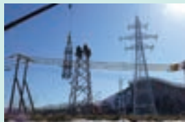
▲ 鉄塔建替工事
