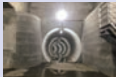
▲ 望月寒川広域河川改修工事(放水路地区)3工区(翌償)
