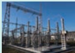
▲ 開閉所改修工事
