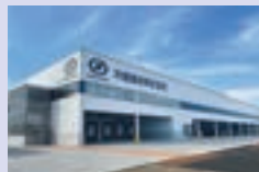
▲ 大槻食材株式会社 錢函物流センター新築工事
