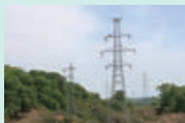
▲ 鉄塔建替工事
