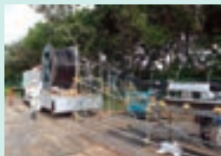
▲ ケーブル延線工事
