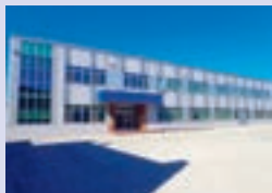
▲ 北海道職業能力開発大学校実習場建替工事
