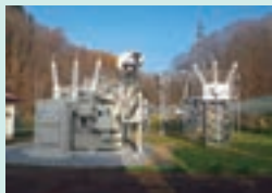
▲ 配電用変圧器他取替工事
