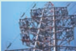
▲ ケーブル延線工事(鉄塔立上)
