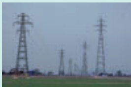
▲ 鉄塔建替工事
