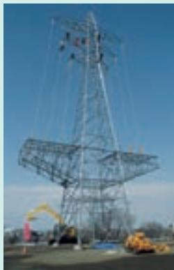
▲ 地中線分岐鉄塔縦ブス架線作業
