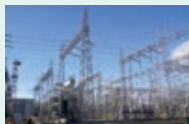
▲ 187kV 連絡用変圧器取替
