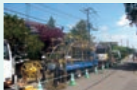
▲ 187kV CVケーブル管路引入
