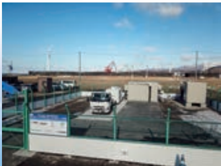
実証施設（室蘭市）水素製造場所の全景
