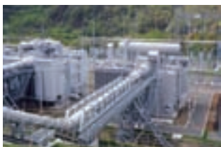
西野変電所275kv連変C増設工事
