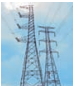
道東幹線要請移設工事
